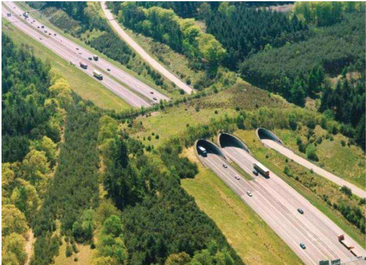
Abbildung 4: Grünbrücke über Autobahnabschnitt zwischen Arnheim und Apeldoorn (Niederlande) ( www.hamco-gmbh.de/de_DE/anwendungsbereiche.html )
